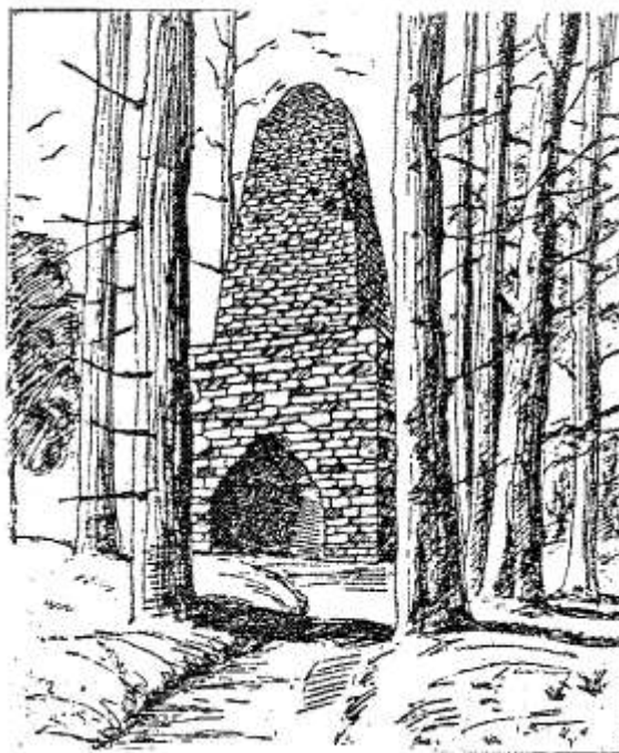
3.9. ábra Magasított bucakemencéből kialakult vasolvasztó
