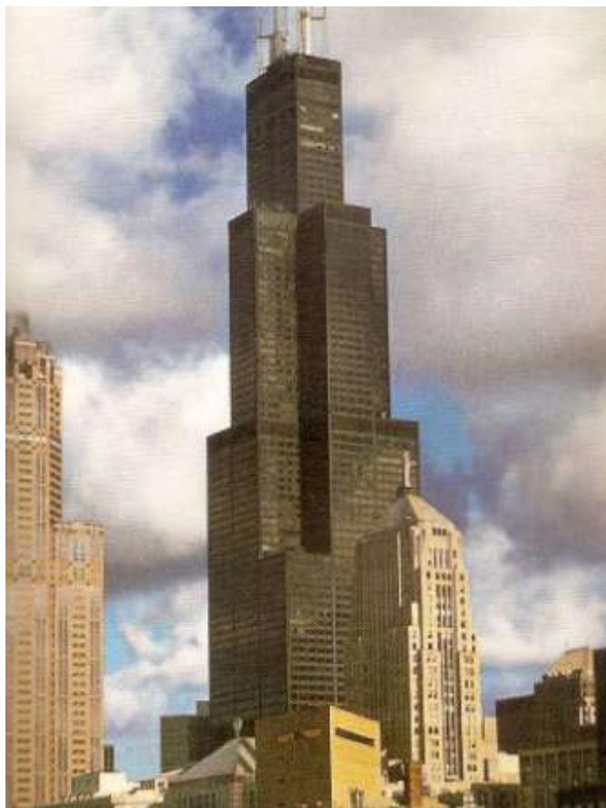
18. ábra Chicagóban épült Sears Tower nevű acélvázás felhőkarcoló (1974: 443 m) [15]
