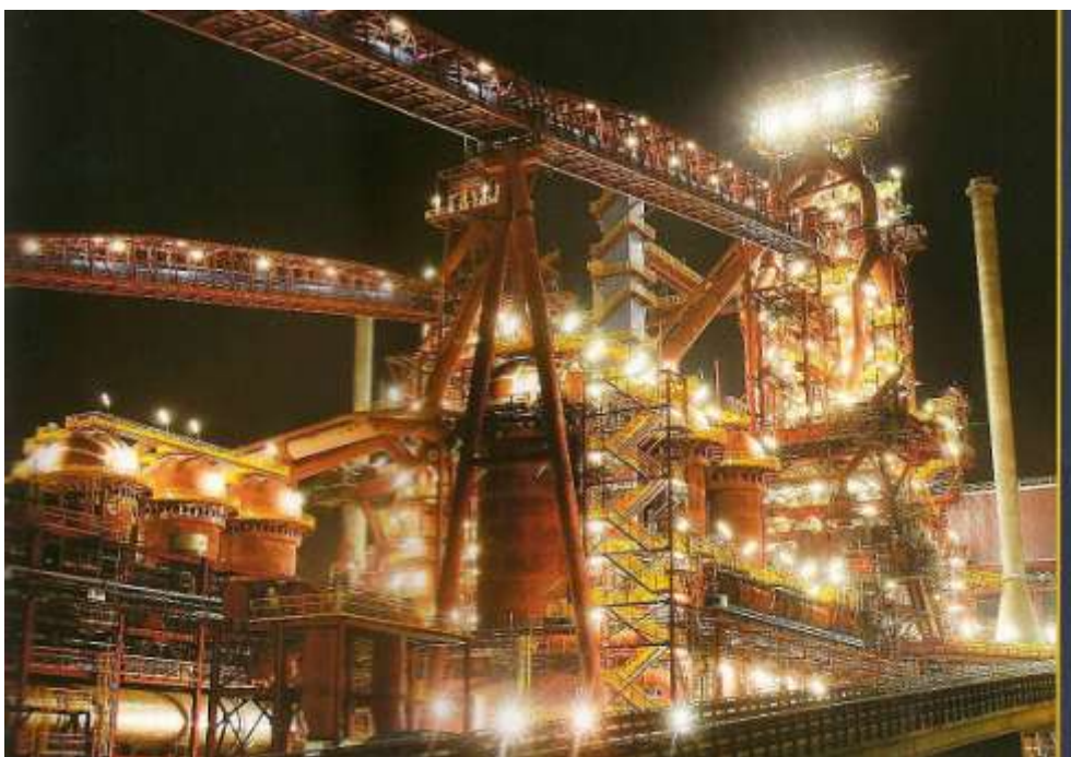
19. ábra MAN által épített luxemburgi nagyolvasztó, léghevítőkkel [16]
